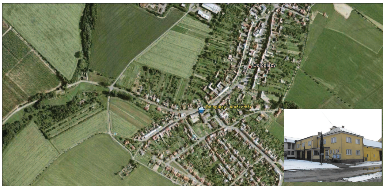
Umístění sirény, srážkoměru a tabule pro neslyšící na budově obecního úřadu v Doloplazech
