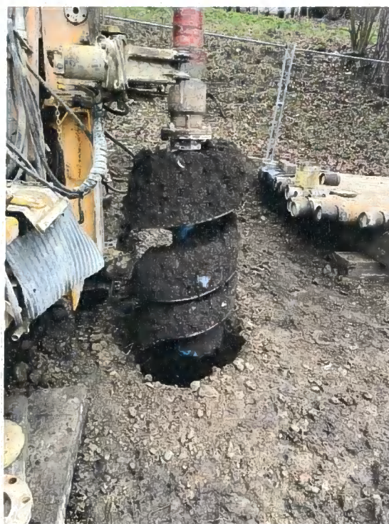
Obr. č. 2: Vrtání spirálem \varnothing 650 mm skrz těleso různorodých navážek.
