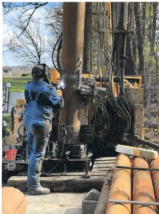
Obr. č. 16: Armorování výstroje.
