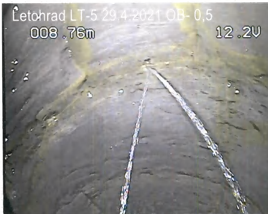
Obr. č. 8 : Přítok z drobné pukliny v hloubce 8,76 m od OB.
