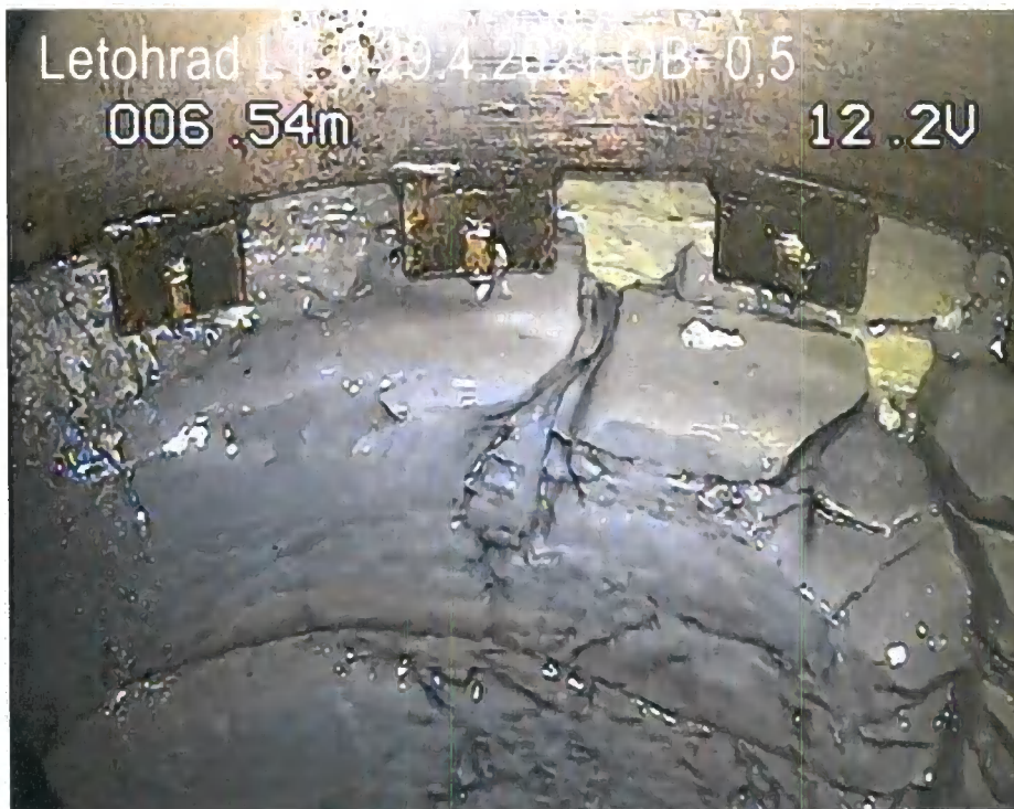
Obr. č. 7: Konec ocelové pažnice o průměru 530 mm v hloubce 6,5 m od OB, porušené, mírně zvětřalé, tmavě šedé prachovité slínovce.
