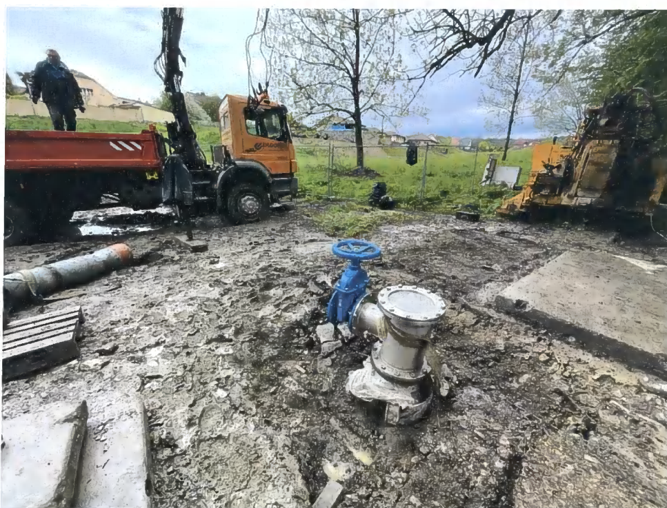
Obr. č. 28: Tlakové zhlaví na vrtu LT-5.
