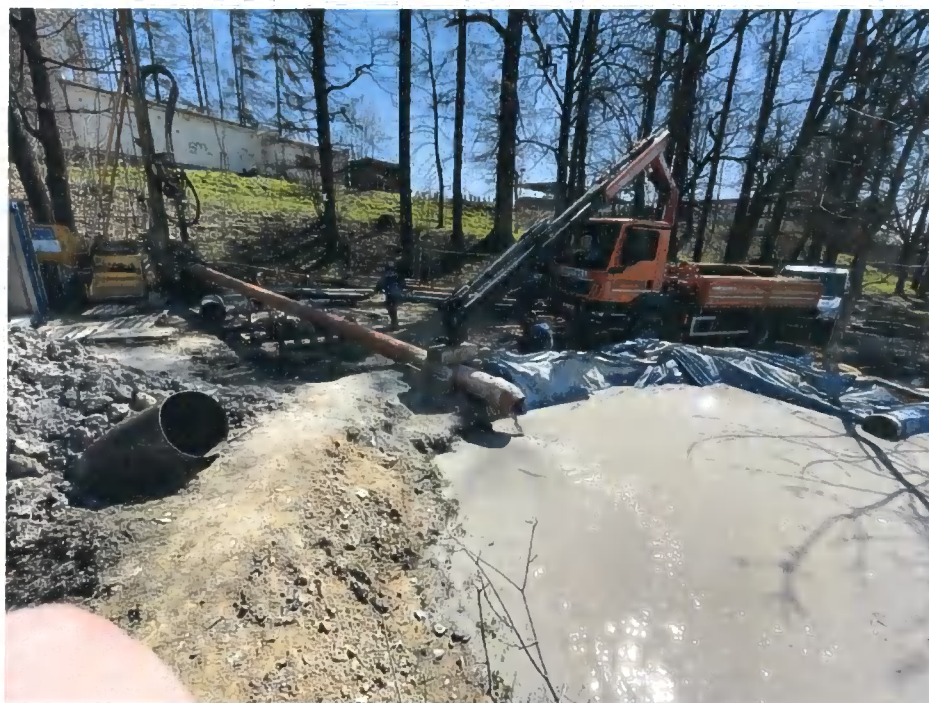
Obr. č. 6: Vrtné práce na lokalitě.
