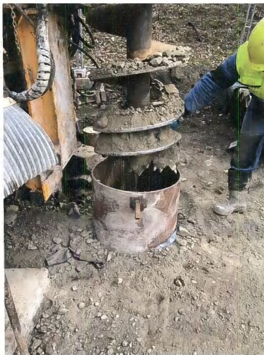
Obr. č. 3: Vrtání spirálem Ø 570 mm.
