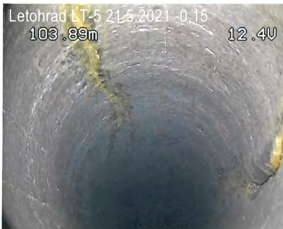
Obr. č. 23: Vyznění hlavní pukliny v úrovni 104,5 m od OB.
