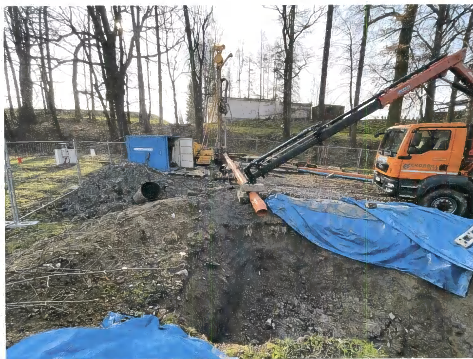
Obr. č. 4: Příprava odkalovací jímky a výplachové hospodářství.
