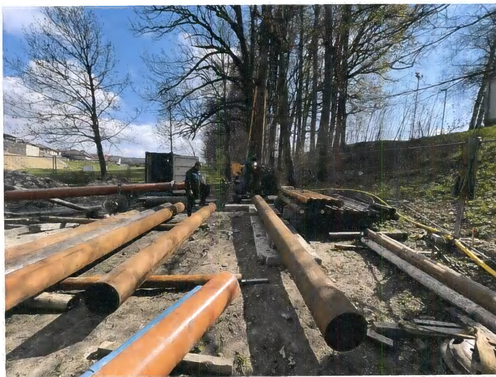
Obr. č. 15: Vystrojovací práce na lokalitě.
