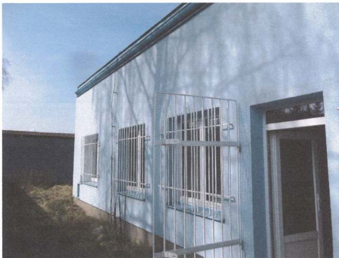
Pohled na část jižní fasády (Zóna 1 – Kanceláře)
