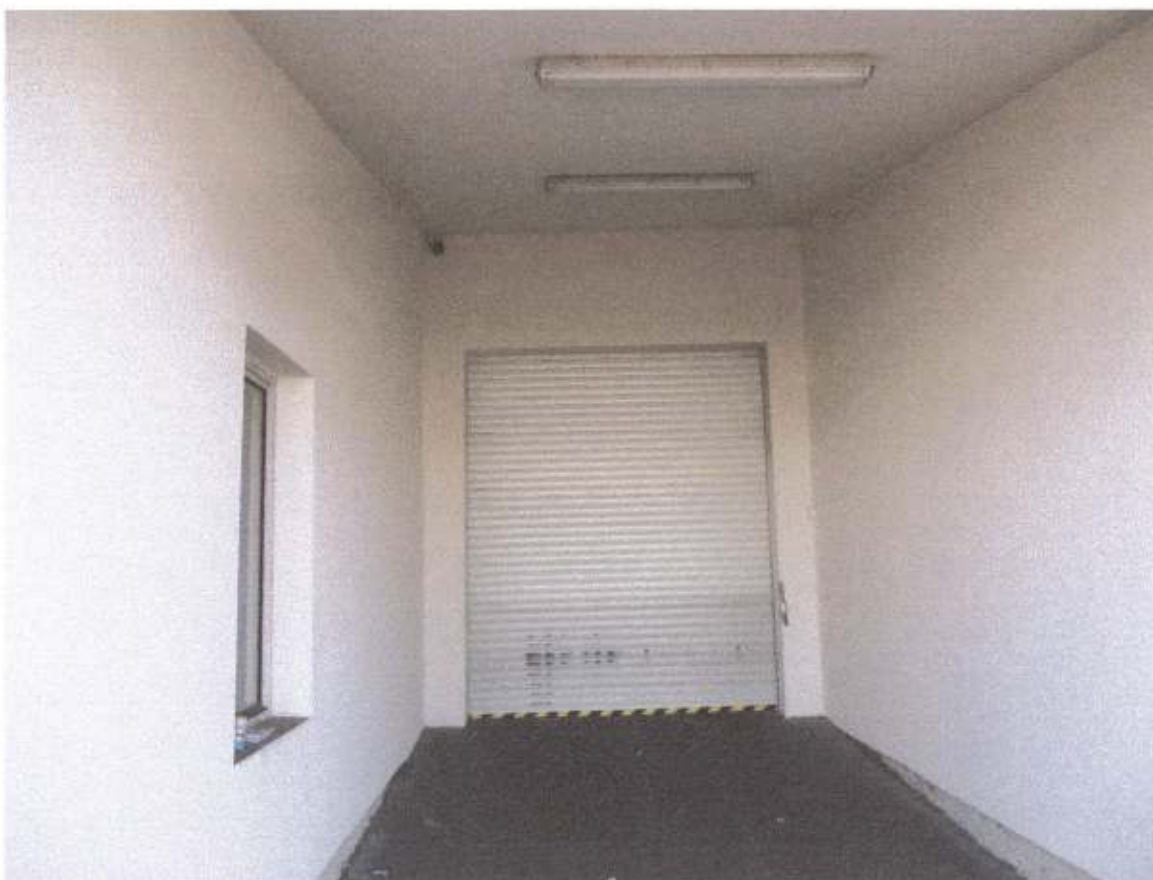
Detailní pohled na vjezd do Zóny 2 – Sklad (severní fasáda)
