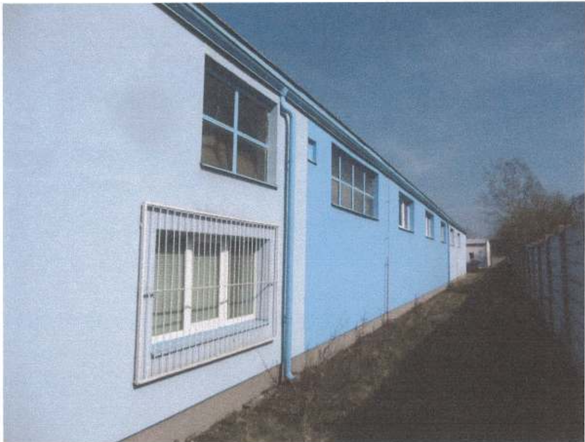
Pohled na část jižní fasády (Zóna 2 – Sklad)
