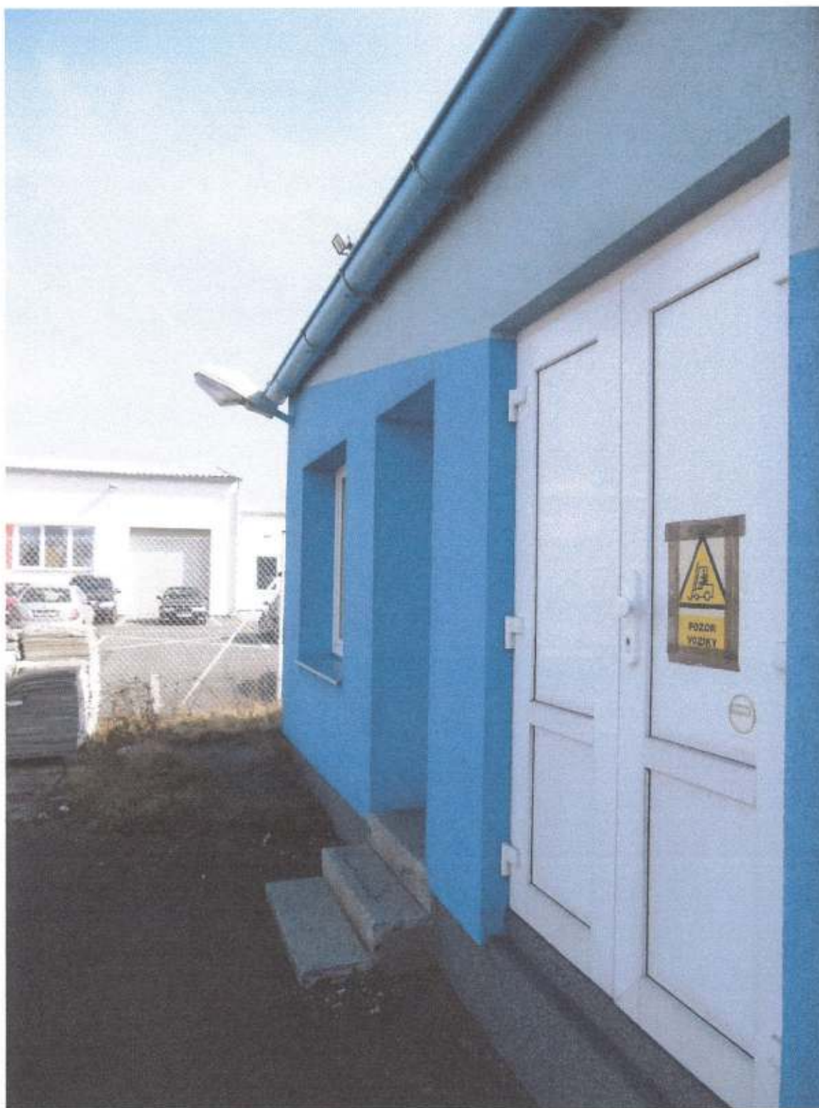
Pohled na část severní fasády (Zóna 2 – Sklad)
