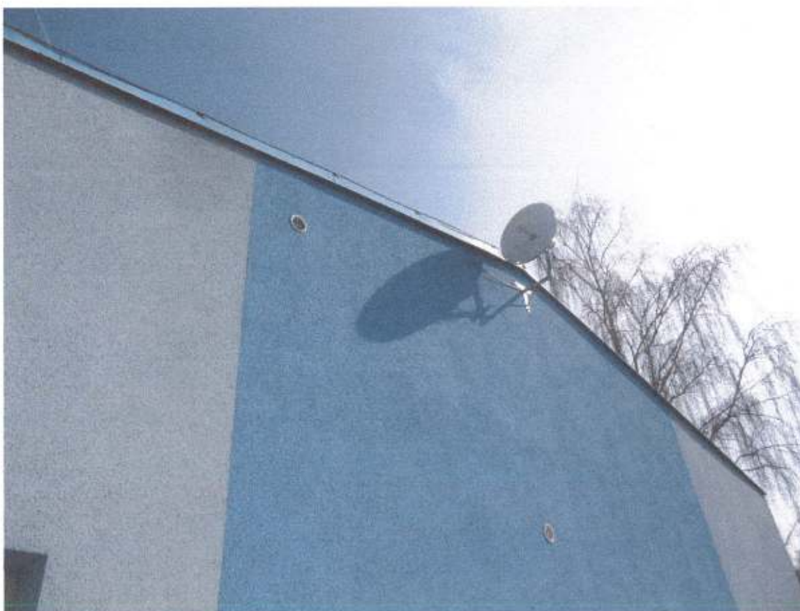
Pohled na část západní fasády
