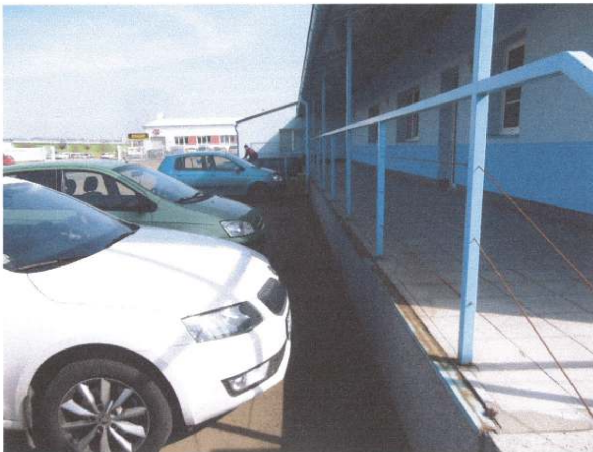
Pohled na část severní fasády (rampa u vstupu do Zóny 1 – Kanceláře)
