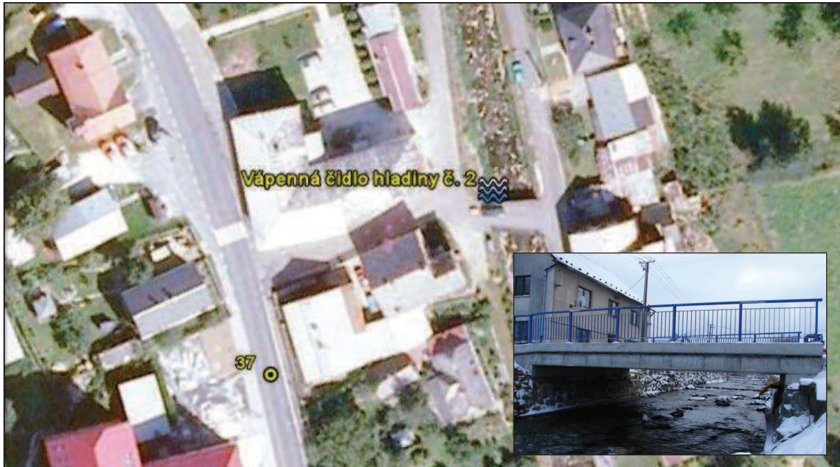
Obrázek Umístění hladinoměru č.2 na Vidňávce
