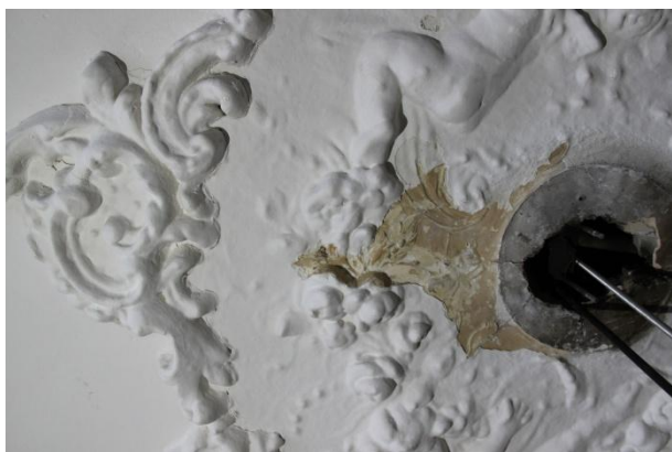
Obr. 13: Sonda So 1, středová rozeta, průzkum modelace pod nátěry
