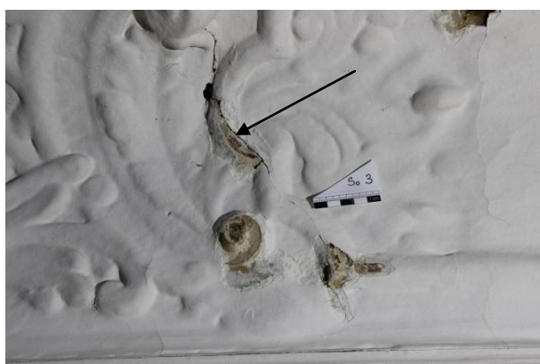
Obr. 9: Sonda So 3, prasklina se nejspíš nachází i v papírmašé, v barevném souvrství se objevuje hnědožlutá vrstva, chovající se jako šelak – je velmi křehká
