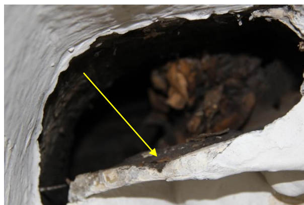
Obr. 12: Kartuše vlevo od dveří, uvnitř prachový depozit, zmačkaný papír, šipka ukazuje na papír nalepený na papírmašé
