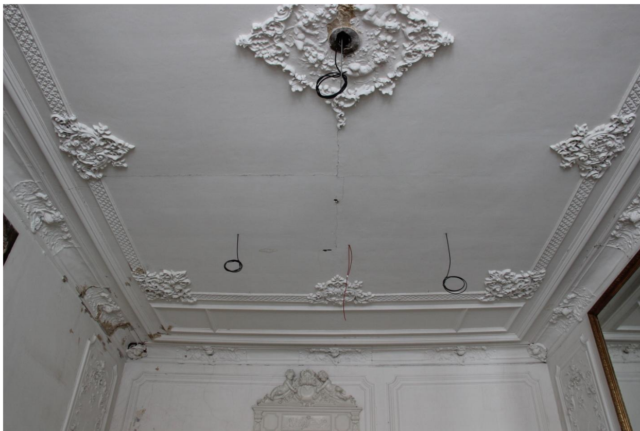
Obr. 20: Pohled na strop od okna k vstupním dveřím
