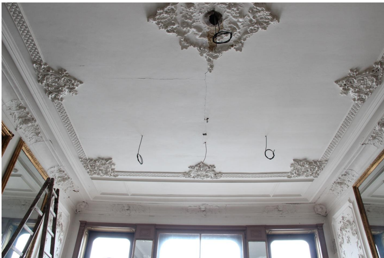
Obr. 21: Pohled na strop od dveří k oknu
