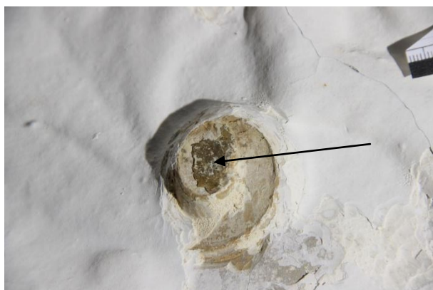
Obr. 11: Sonda So 3, na volutě se nachází zbytky nepravého zlacení práškovým bronzem
