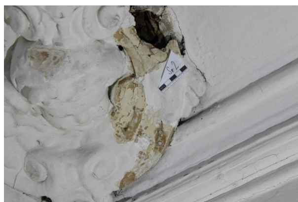
Obr. 10: Rozšířená sonda So 2, průzkum modelace pod nátěry, lokální zlacení
