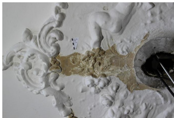
Obr. 14: Sonda So 1, středová rozeta, průzkum modelace pod nátěry, objeveno lokální zlacení bronzovým práškem
