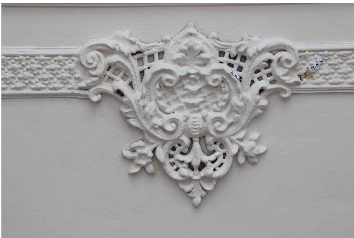
Obr. 24: Menší stropní dekorace rozdělující mřížku, celkem 6 kusů
