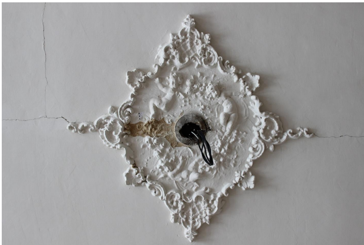
Obr. 27: Středová stropní rozeta s otvorem na lustr
