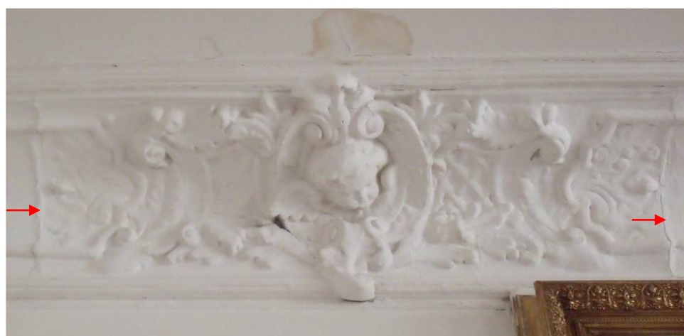
108 – pohled na fabion s vyznačením spár – ukončení pole
