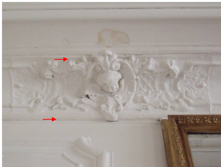
107 – pohled na fabion s vyznačením spodní a horní profilace
