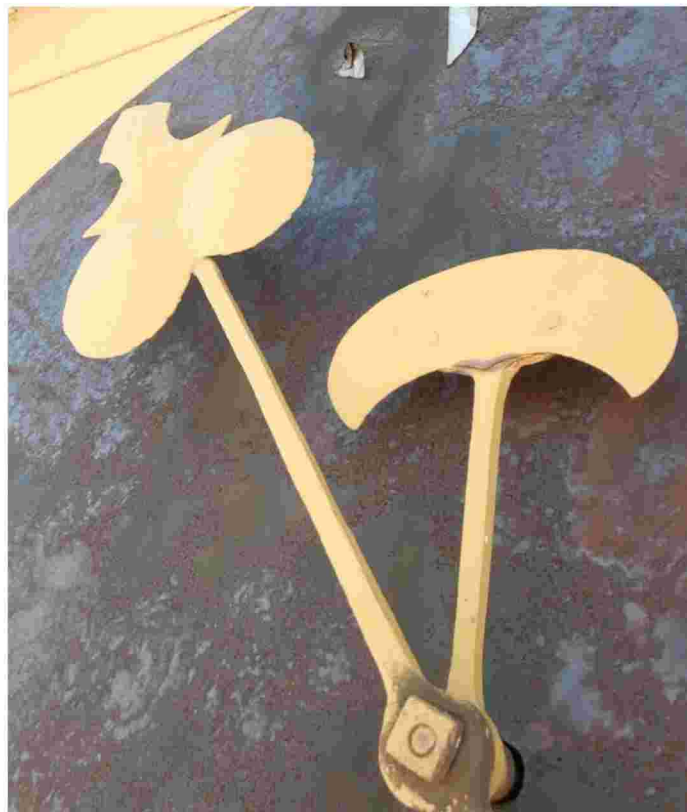
Rafije bočního ciferníku, degradace povrchu pláště ciferníku
